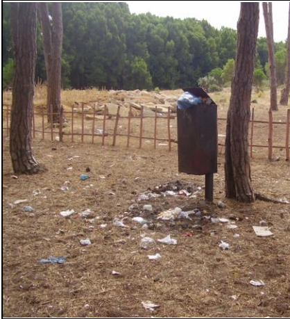
Cliché Brahamia Khaled 2006 Photo n° 8 Etat de dégradation des poubelles Aire de repos Tonga
